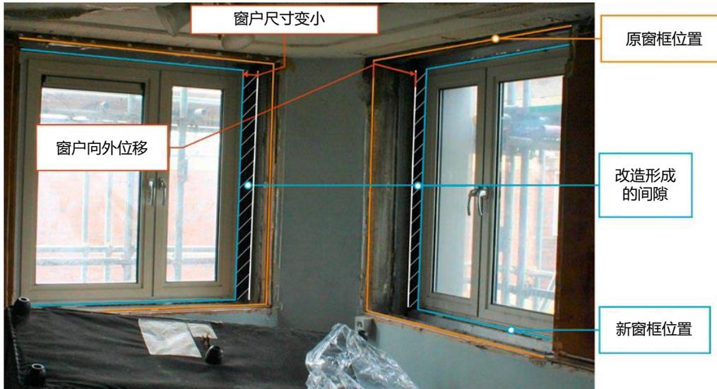
图 6.9 窗户外移及尺寸变小形成的间隙
