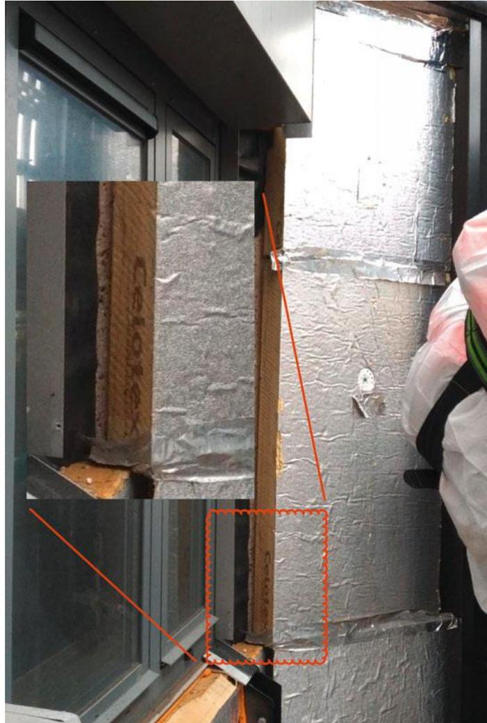
图 6.4 绝缘板之间的接缝用铝箔胶带粘接
