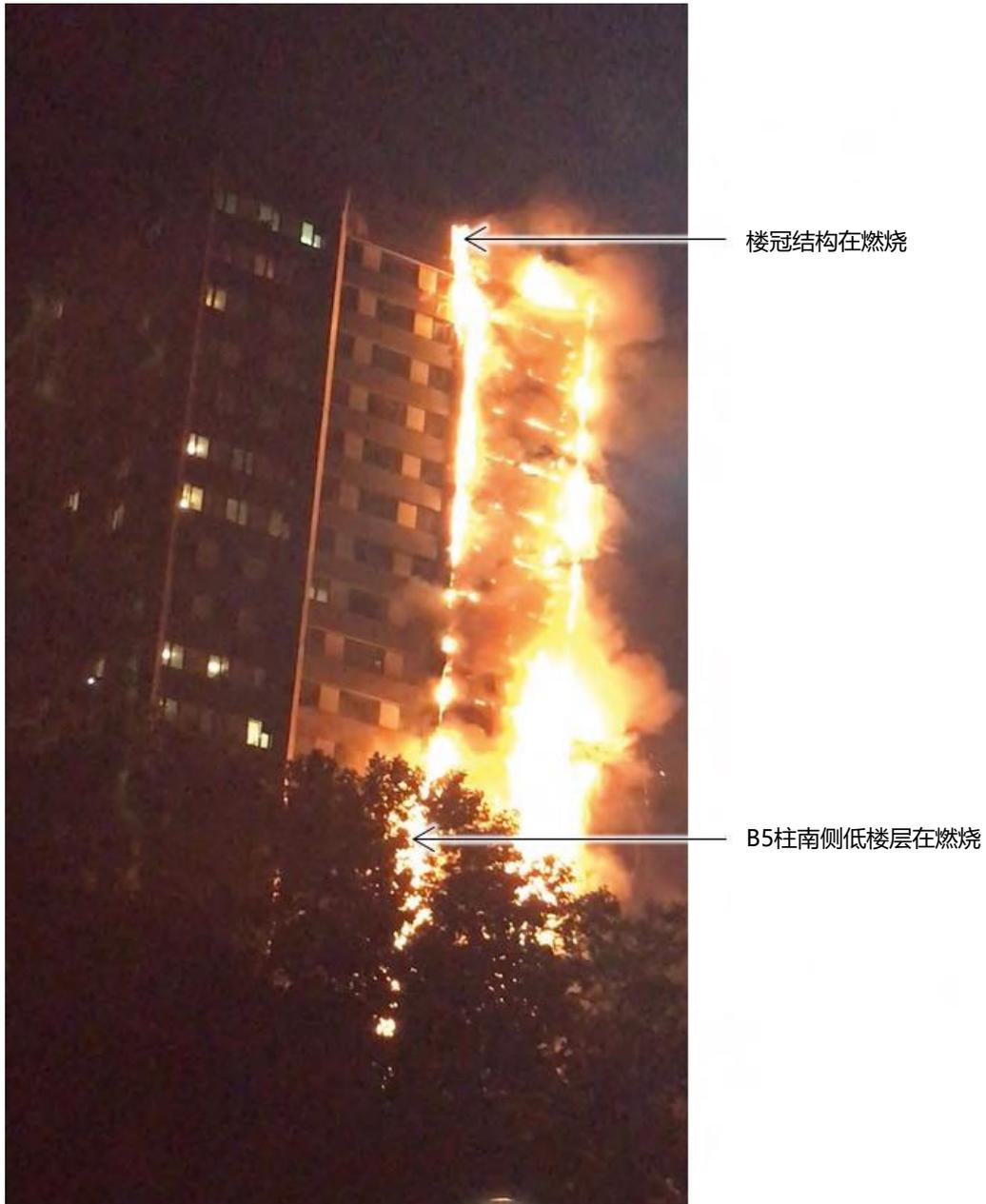
图 11.2 楼冠结构和 B5 柱南侧低楼层在燃烧
