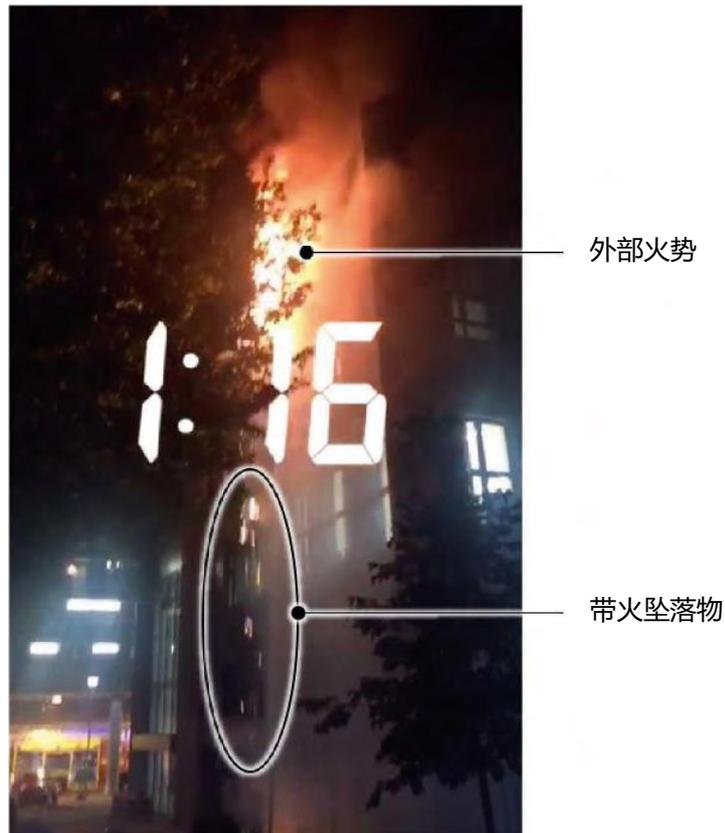
图 10.13 短视频显示大厦外部火势和带火坠落物
